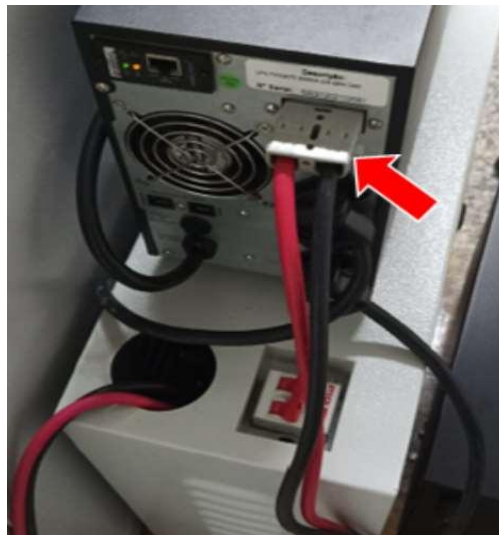
Figura 4: Conector BAT50 do banco de baterias
