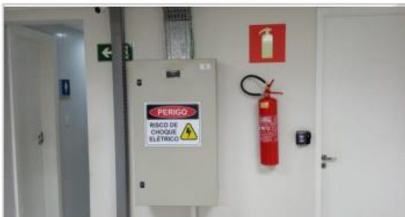
FOTO 53 - Vista do quadro do 1º Pav - Prédio 01.
