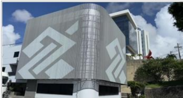
FOTO 25 - Detalhe da fachada - Brises.
