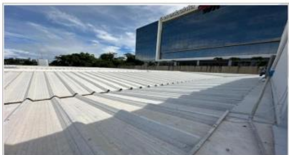
FOTO 108 - Vista da cobertura revisada.
