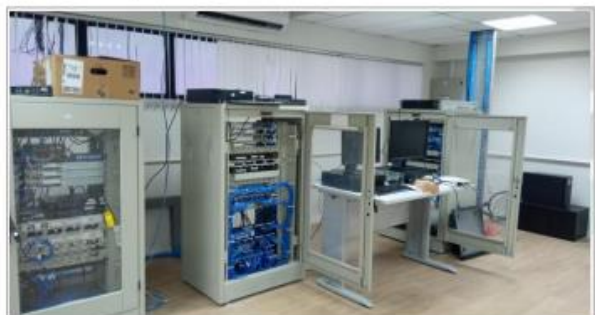
FOTO 30 - Vista complementar da Sala do CPD.
