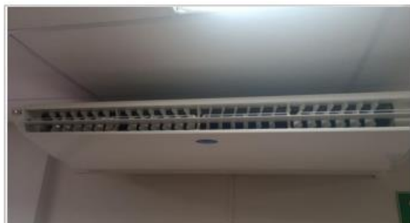
FOTO 110 - Evaporadora piso-teto.
