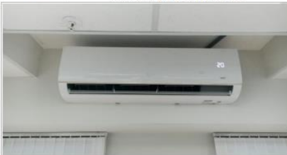
FOTO 113 - Evaporadora HW de 12K - Midea
