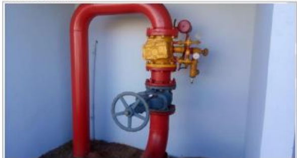
FOTO 62 - VGA 02 devidamente revisada.
