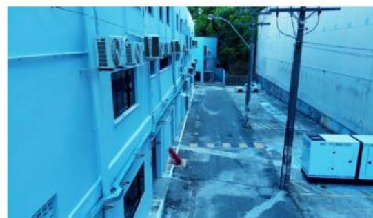
Vista Lateral Estacionamento
