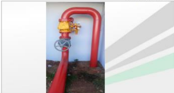
FOTO 61 - VGA devidamente revisada.
