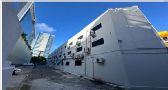
FOTO 69 - Vista da fachada lateral.
