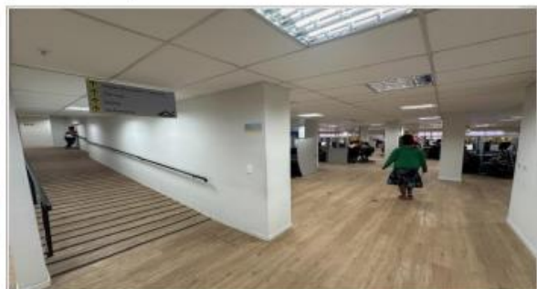
FOTO 77 - Rampa de acesso ao balanço.
