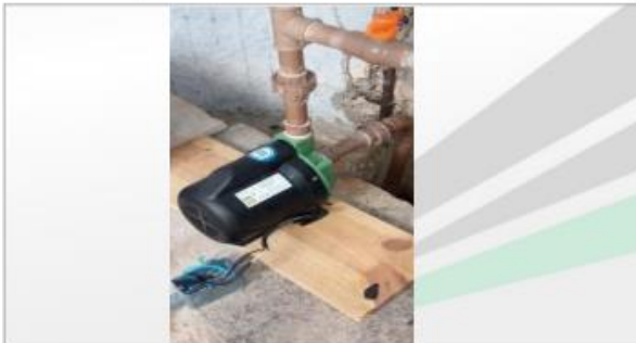
FOTO 27 - Bomba de recalque castelo - Prédio 02.
