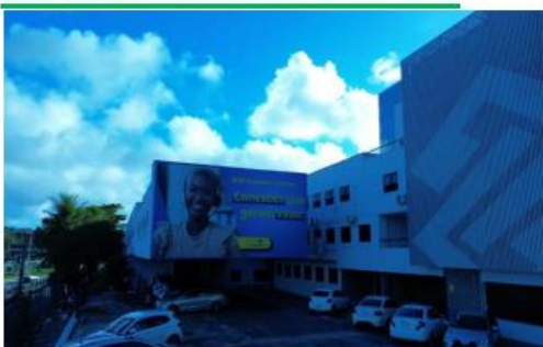
Vista frontal Fachada
