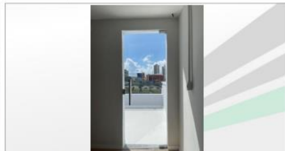
FOTO 08 - Porta de vidro e varanda revitalizada.
