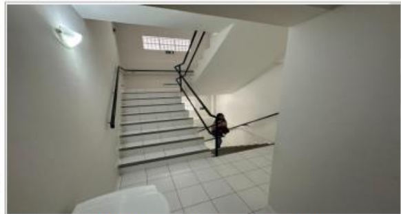
FOTO 80 - Escada de acesso Prédio 01.
