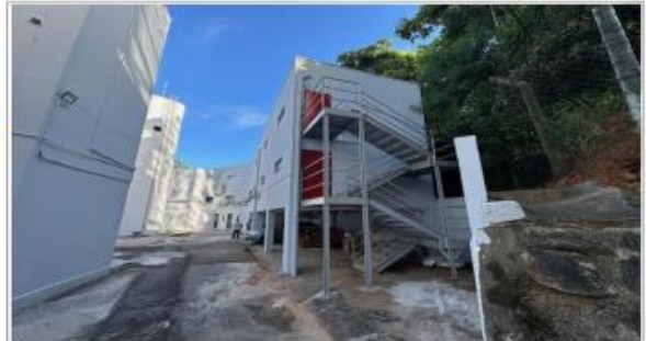
FOTO 70 - Vista fundo da edificação.
