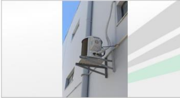
FOTO 111 - Condensadora Springer 12 K.
