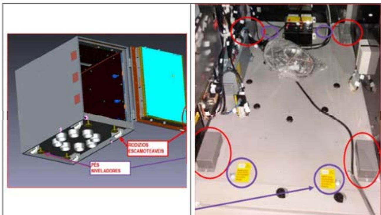
2.15. Retirar o gabarito ou afastar o TAA / RECICLADOR e realizar os furos perpendiculares ao piso (ângulo de 90°) utilizando a broca de aço viede longa de 20 mm até a profundidade de 150 mm.
